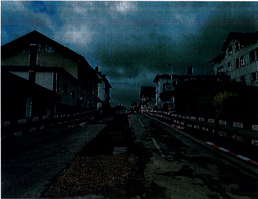
Rénovation des réseaux souterrains à la rue du Midi.
