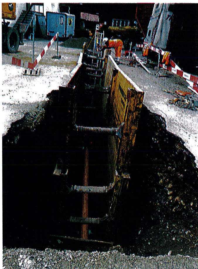
Raccordement de la piscine au réseau d'eau usées (Sur le Pont).
