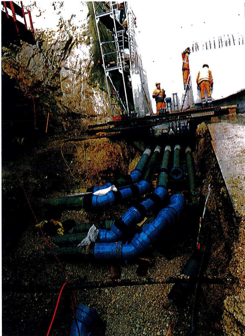
Pose de conduites devant le réservoir 1935 (en rénovation).
