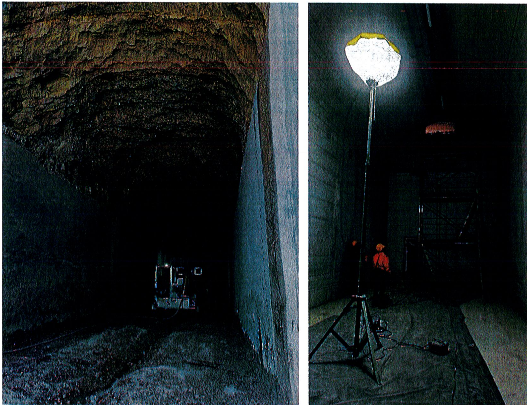
Rénovation du réservoir 1935 Sur les Crêts (mise en service début 2023).
